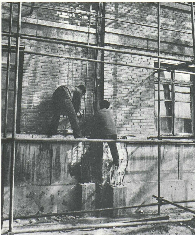
Fig. 5. — Pose des armatures pour un tronçon de nervure vertical.
