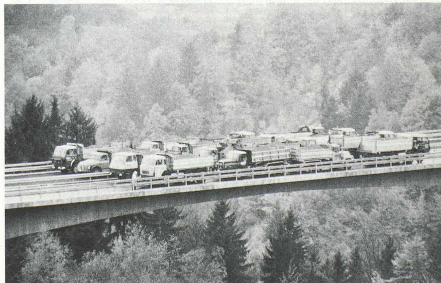
Fig. 17. — Essai de charge de réception d'un ouvrage neuf.
