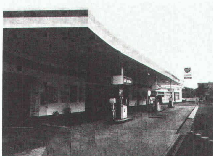
Station d'essence Revêtement flexible étanche et résistant aux huiles
