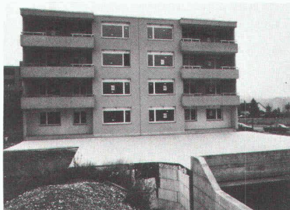
Dalle sur garage enterré Revêtement étanche sous terre
