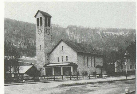
5210 Villeret 1961 Chapelle catholique, Arch. Bueche Jeanne
