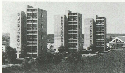
3119 Bern 6, Bethlehem 1956-58 Erste Betonhochhäuser, in Gesamtsiedlung Neuhausweg 21-25, Arch. Helfer AG
