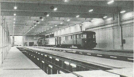
0187 Spiez 1982-86 BLS-Depot, Werkstatt- und Kranhalle, mit Seitengruben und Hochperrons, Ing. Theiler K., Arch. Lanzrein & Partner
