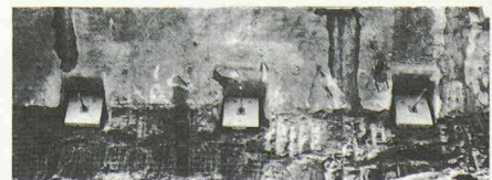
3204 Bern 2, Enge 1984 Bedag: 22 m tiefe Baugrube in Molasse, Engenthalstrasse, Ing. Weber + Brönnimann AG
