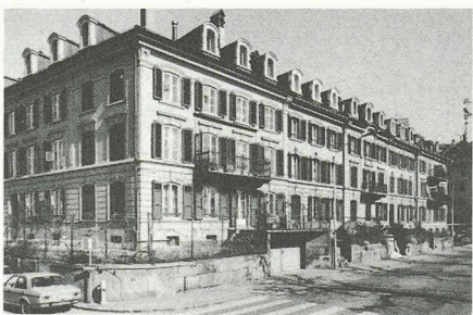
Exemple important de classicisme bernois avec façades en molasse et coursives côté cour pour la construction de logements
