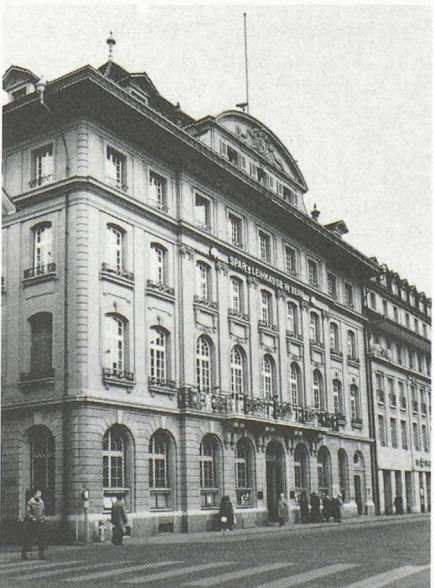
3062 Bern Altstadt 1912-13/78-80 Spar- und Leihkasse, Bundesplatz 4, Arch. Joss Eduard, Umbau: Atelier 5
