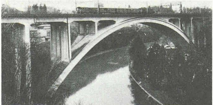
3091 Bern 5, Lorraine 1937-41 Eisenbahnbrücke, Ing. Bühler Adolf
