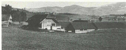
0240 Reutigen 1980/81 Kant. Fischzuchtanstalt, Arch. Baeriswyl Pierre
