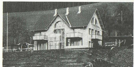
2312 Gümliigen 1984 Einfamilienhaus Furrer, Arch. Althaus Jürg
