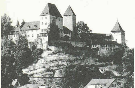
8126 Burgdorf 1974-83 Schlossfelssanierung nach denkmalpflegerischen Anforderungen Assainissement de roches au château selon les critères de la protection des monuments et sites, Ing. Steiner + Buschor AG, Publ. Bericht Kt. Baudirektion 5/1984
