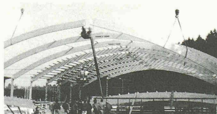
9119 Langenthal 1982-84 Überdachung Kunsteisbahn, Ing. Duppenthaler + Wälchli
