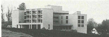
2410 Münchenbuchsee 1978-79 Altersheim, Arch. Hebeisen und Vatter
