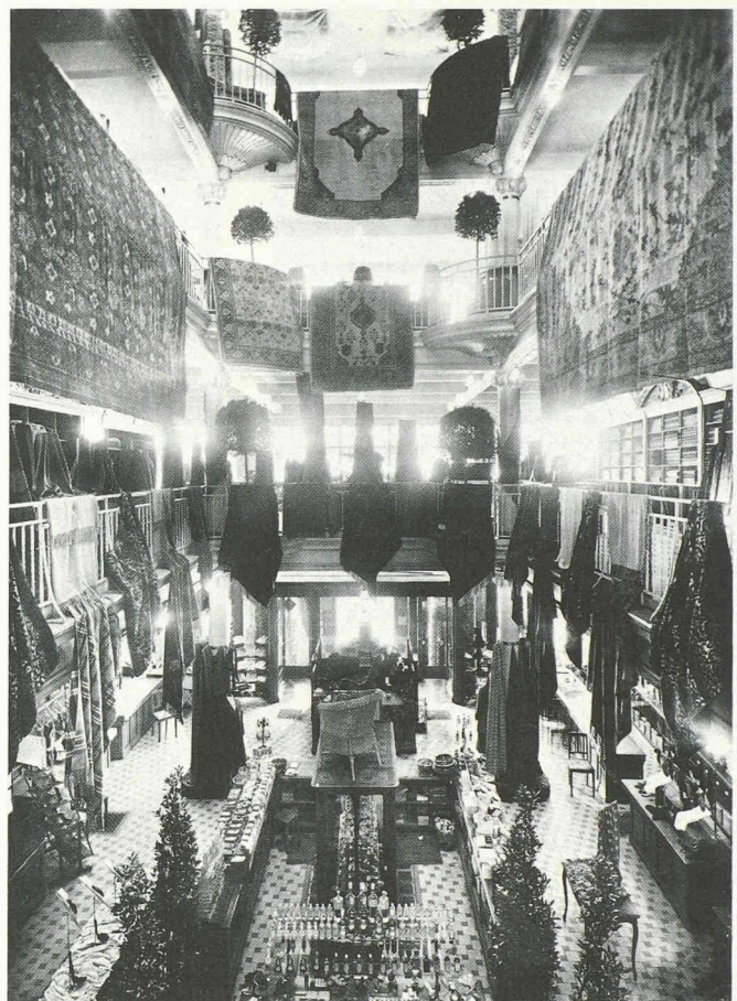
Fig. 10. — Vue des galeries en exploitation, août 1921.
