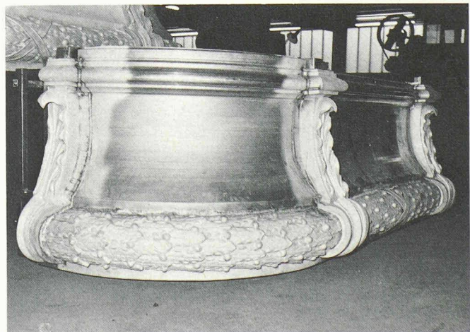
Fig. 17. — Assemblage des contrecœurs inférieurs d'un bow-window ayant déjà reçu ses palmettes et ses guirlandes en zinc.
