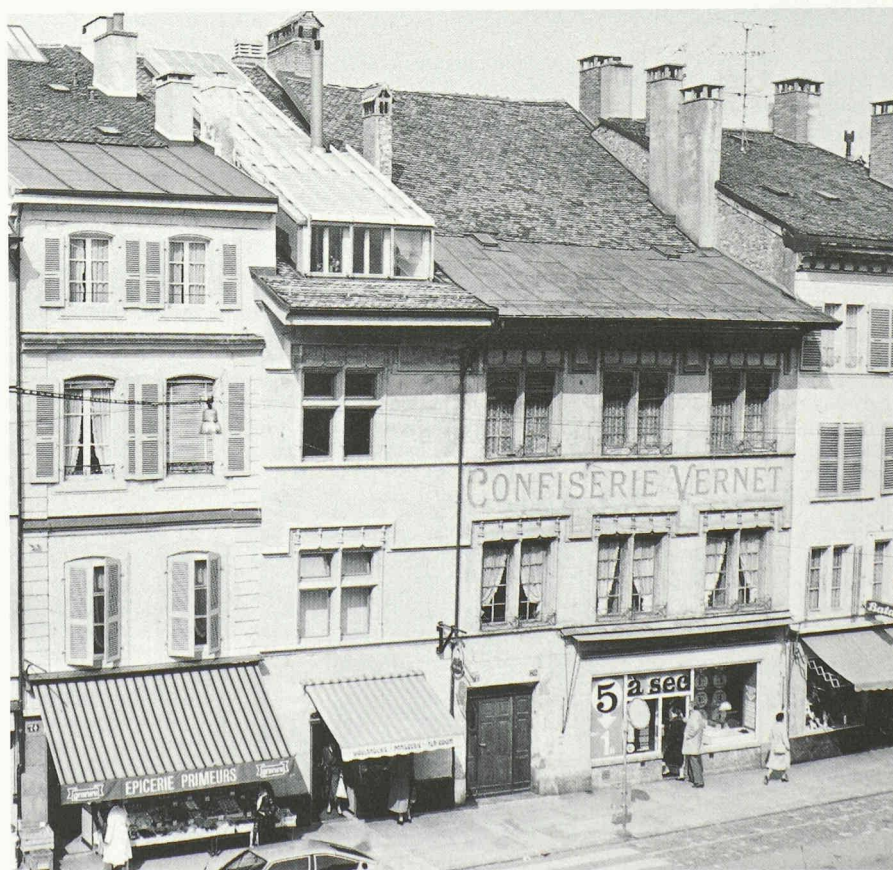
La façade sud restaurée.
