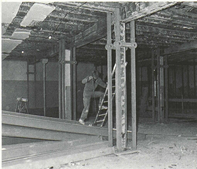
Fig. 5. — L'unité structurelle : la paire de poteaux.
