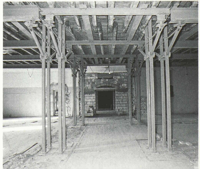
Fig. 6. — L'ancienne structure fait place à la nouvelle.
