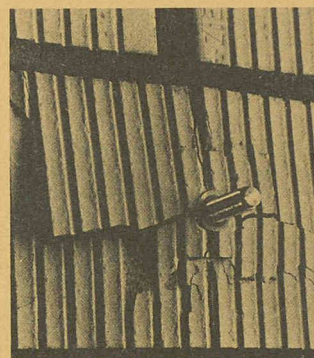
Essai d'arrachement dans la maçonnerie creuse: la fixation résiste, la maçonnerie éclate.
