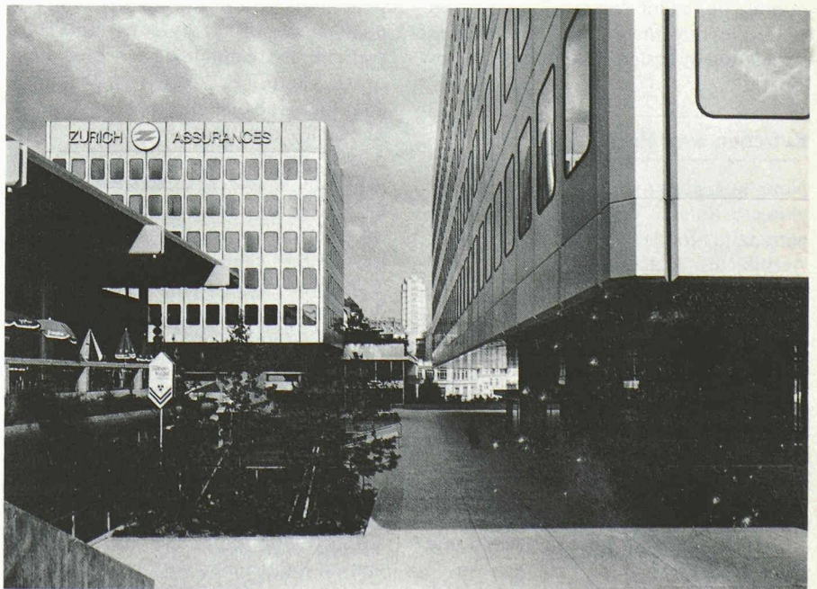
Fig. 2. — Bâtiments administratifs, place Chauderon (Lausanne).
