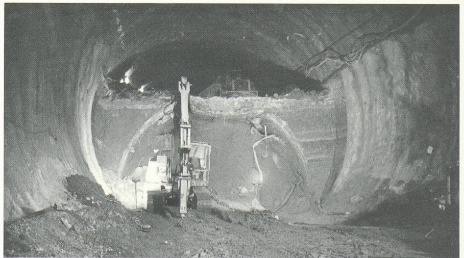
Le tunnel du Rollenberg en cours de travaux (extrémité ouest).
