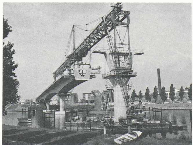
Fig. 7. — Viaducs de Nantua-Neyrolles.
