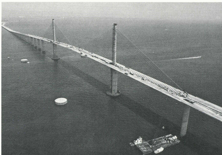
Fig. 12. — Pont du Sunshine Skyway, vue d'ensemble de la travée haubanée.
