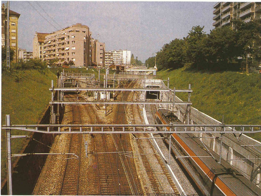
La bifurcation de Saint-Jean aujourd'hui: les deux voies entrant dans le tunnel sont électrifiées en courant CFF, de même que les deux voies à ciel ouvert en direction de Châtelaine et de l'aéroport; tout à droite, la voie s'engageant dans le tunnel du saut-de-mouton est électrifiée en courant continu SNCF.
