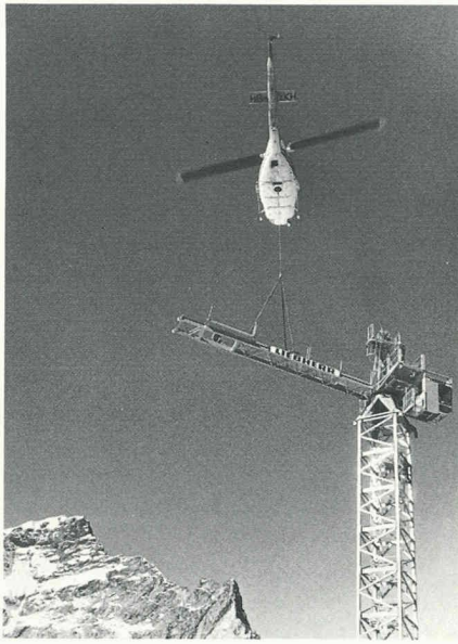
Fig. 10. — Pour le montage des grues de chantier, il a été nécessaire de recourir à l'hélicoptère.
