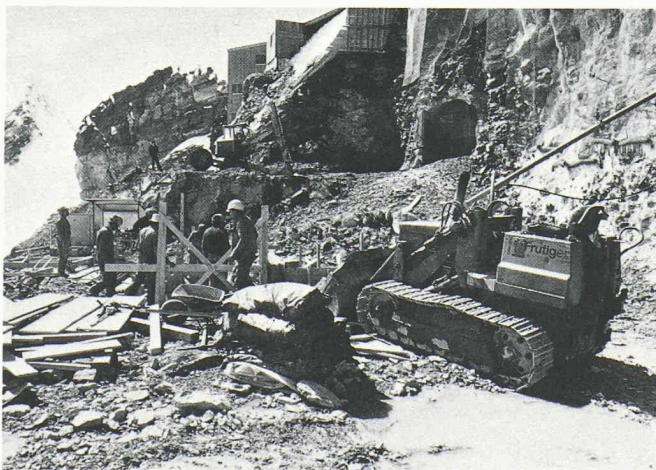
Fig. 4. — Il a d'abord fallu créer une plate-forme où puissent évoluer les machines de chantier.
