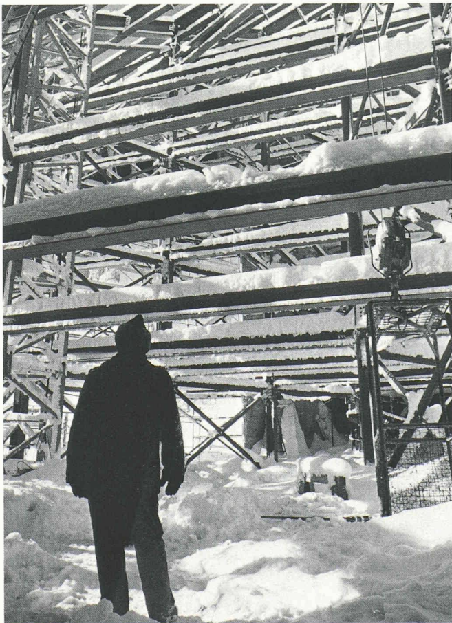
Fig. 8. — Cette vue donne une idée des conditions météorologiques dans lesquelles s'est fait le montage de la charpente métallique du bâtiment.
