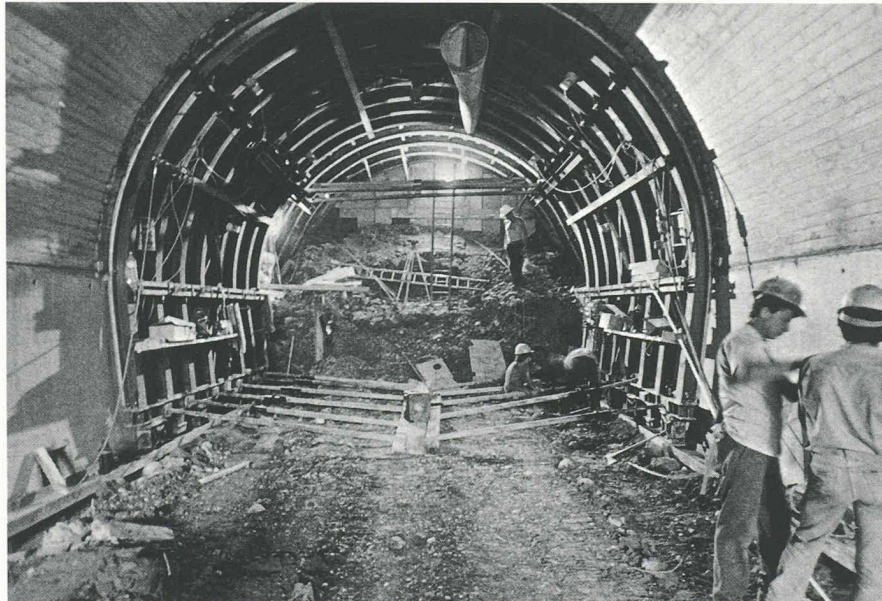
Fig. 11. — Le tunnel en cours de travaux. (Photo Murat, Genève.)
