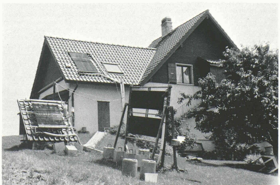
Vue d'ensemble de l'installation de la recherche EINEV.
