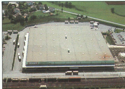
▲ Suisse : Centre de distribution Denner, Schmittlen.
