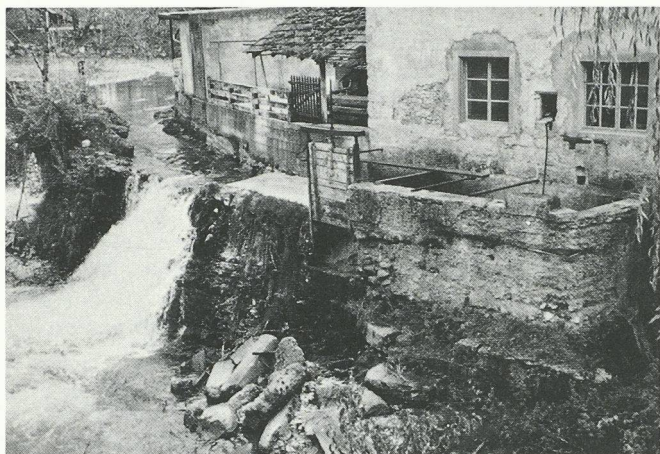
Fig. 12. - Site 3 - Vue générale avant rénovation.
