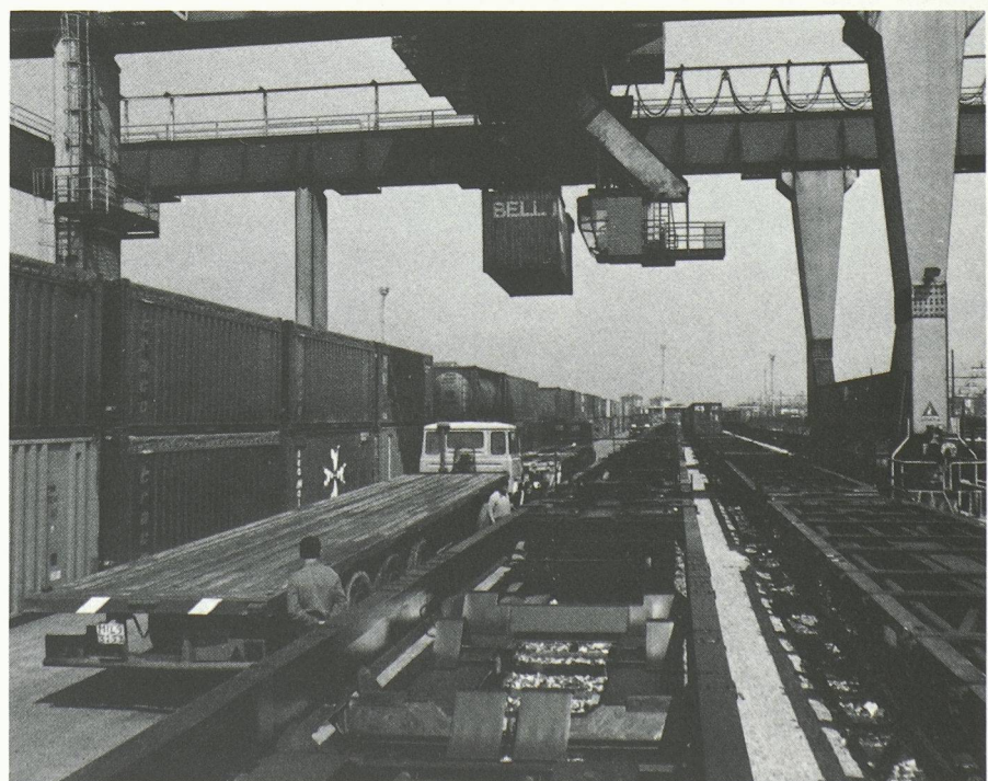
La manutention rationnelle et rapide des conteneurs demande d'importantes infrastructures. (Photo: gare de trafic combiné de Milan.)
