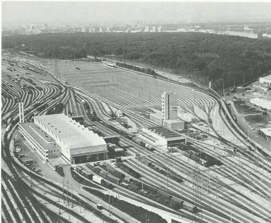
Sous n'importe quelle forme, le transit des marchandises exige d'importants investissements d'infrastructure. Ici, la gare de triage de Muttenz II, construite il y a quelques années pour recevoir exclusivement le transit sud-nord, Muttenz I étant dès lors réservé au trafic nord-sud.
