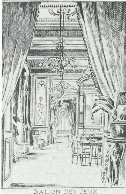
Besançon, le casino des Bains. Salon des jeux (Forien, architecte, 1893).
