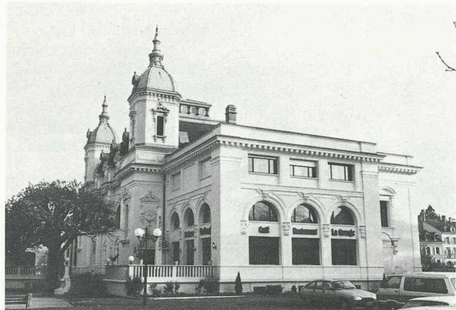
Vue du bâtiment au midi avant la restauration de 1984.
