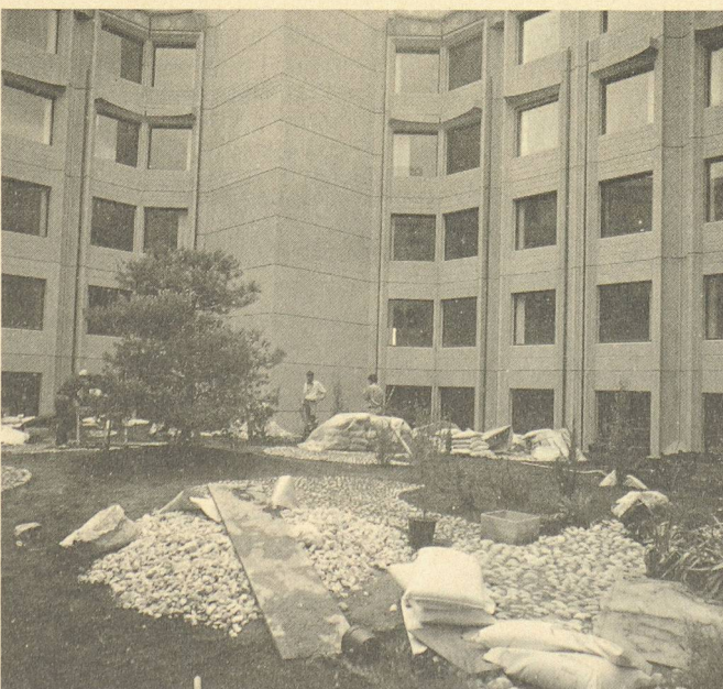
Fig. 2. – Sur la couche drainante et la terre végétale, les plantations peuvent commencer.
