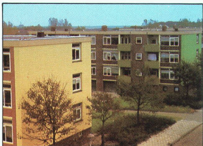
▲ Pays-Bas : Rénovation de logements à Den Helder.
