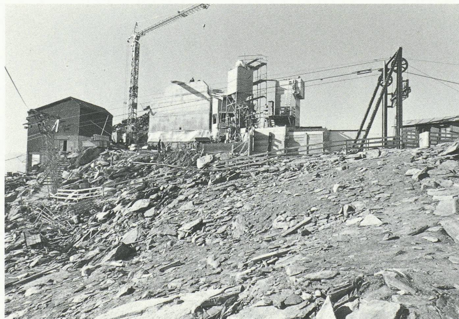
Fig. 1. - Vue générale du chantier; de g. à d.: station du téléphérique, au premier plan le téléphérique de service avec son pylône d'arrivée, au milieu s'élève le bâtiment principal. L'engin de levage ainsi que la tour à béton ont été acheminés en pièces détachées au moyen du téléphérique de service.
