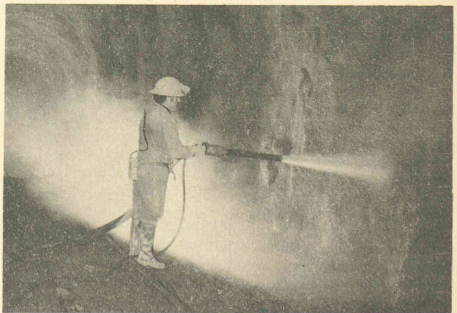
Application de béton projeté dans un tunnel.
