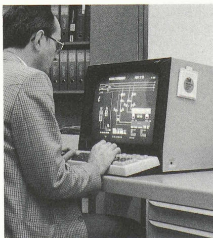
Fig. 4. - Pour l'entretien et le bon fonctionnement de l'ensemble des installations techniques de l'UBS, l'écran couleur permet de visualiser n'importe quelle partie de l'installation et ses données.
