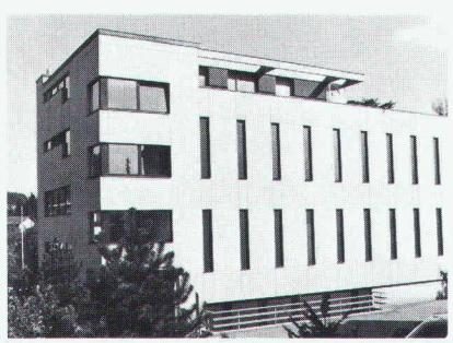
Bâtiment des télécommunications à Unterengstringen
