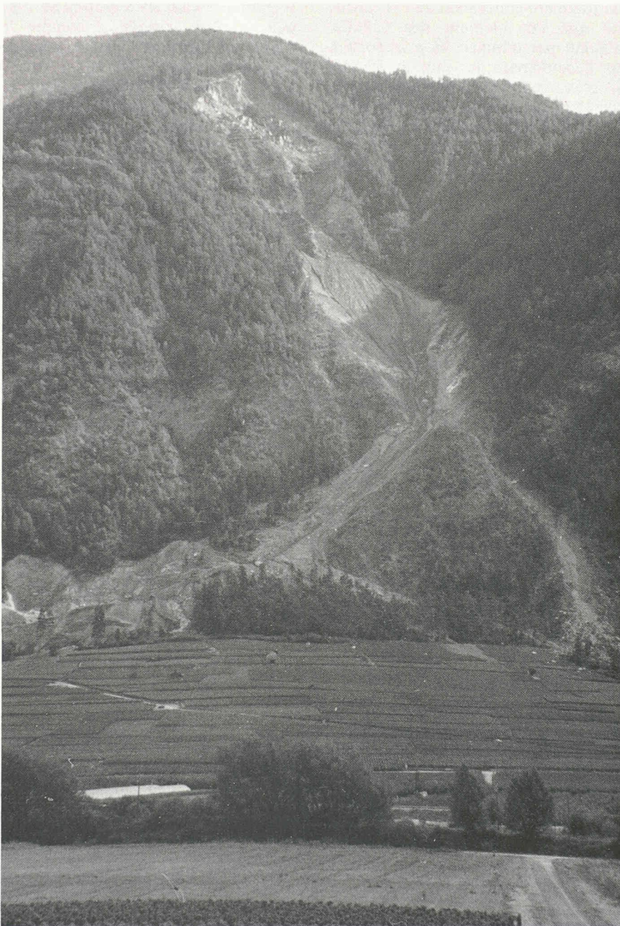
Fig. 4. – L'éboulement des Crêtaux en octobre 1987.
