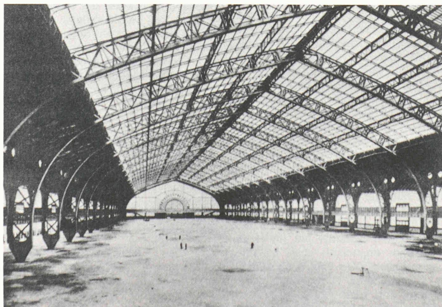
Halle des machines à l'Exposition universelle Paris, 1889. Architecte : L. Dutert. Ingénieur : F. Contamin.
