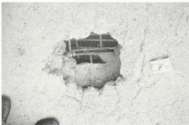
Fig. 9 et 10. – Nid-de-poule découvert un matin dans la dalle de couverture d'un pont en béton armé, près de Reims. C'est seulement ce jour-là qu'on est allé examiner l'ouvrage par en dessous (accès facile sans moyens spéciaux). Bon nombre de panneaux délimités par les poutres principales et les entretoises étaient depuis un certain temps déjà dans un état de dégradation comparable (au trou près) et on ne s'en était jamais aperçu.
