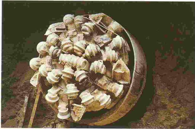
Tunnel est. Le tunnelier pilote (Wirth TB I E) atteint le sommet d'un des deux puits de ventilation de la future centrale des Perrolets, après avoir fraisé 650 m de roche. La tête rotative du tunnelier est équipée d'outils de coupe en métal trempé. A cet endroit, la machine est démontée et évacuée. L'étape suivante consiste en l'élargissement du puits pilote jusqu'au diamètre final ( \phi 5,75 m), de haut en bas, à l'aide d'un tunnelier-aléreur (Wirth TB E IV). Ce système de forage offre, dans des conditions géologiques favorables, de nombreux avantages: aucun hors-profil n'est mis en évidence, ce qui se traduit par un gain de béton, entre autres; les travaux de soutènement se trouvent considérablement réduits; le personnel de chantier est enfin beaucoup mieux protégé que pour tout autre type de creusement. (Photo prise le 13 mai 1987.)
