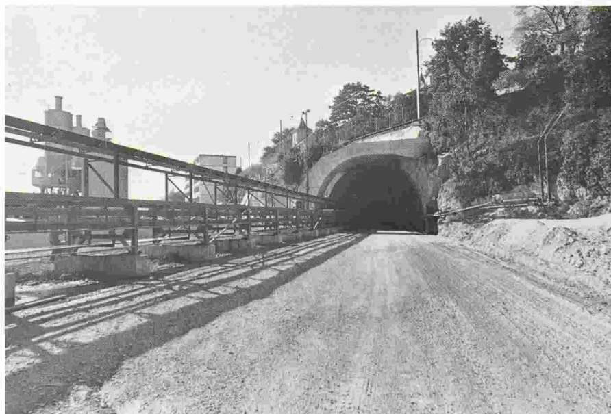
Tunnel est. L'évacuation des déblais depuis le transporteur de l'alésoir jusqu'à l'extérieur du tunnel se fait par un transporteur unique à bande courbe d'environ 2500 m.
