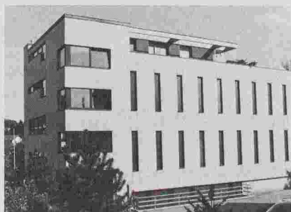
Bâtiment des télécommunications à Unterengstringen
