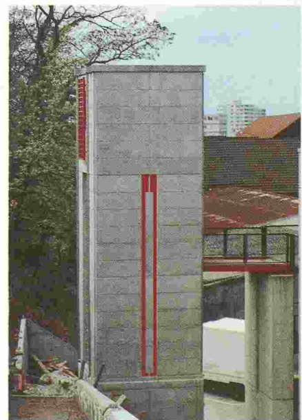
Fig. 4. – Monte-charge construit en remplacement de la passerelle.
