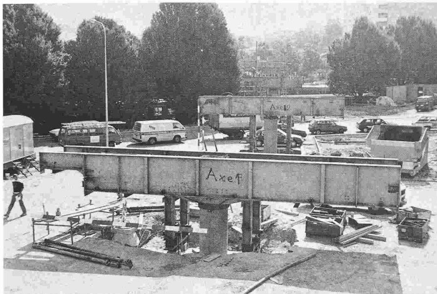
Fig. 2. - Viaduc de Sévelin: coffrages métalliques des piles.
