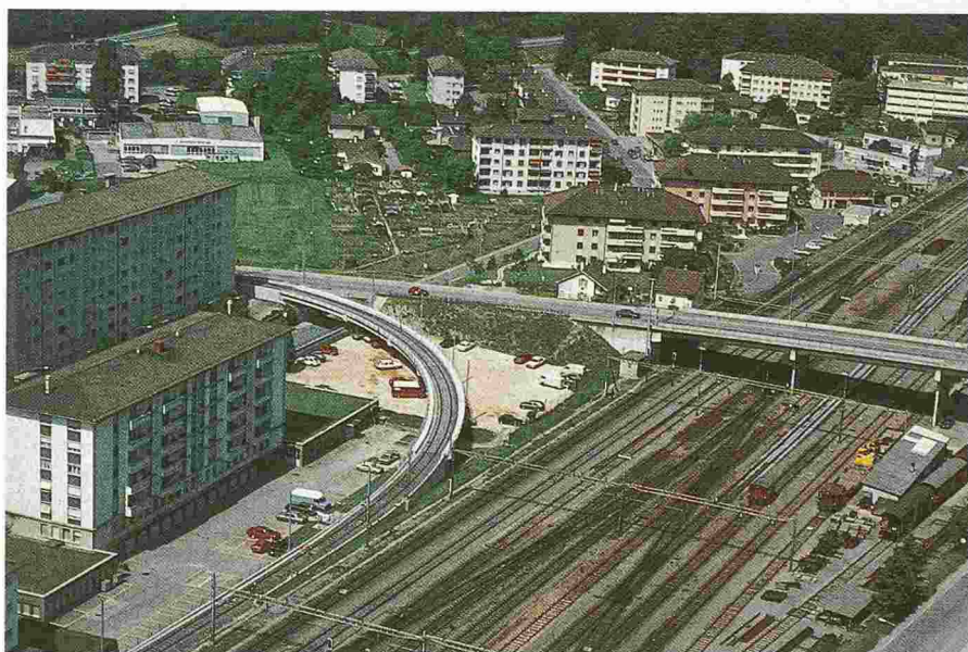
Fig. 26. - Pont d'Epenex: vue aérienne.
