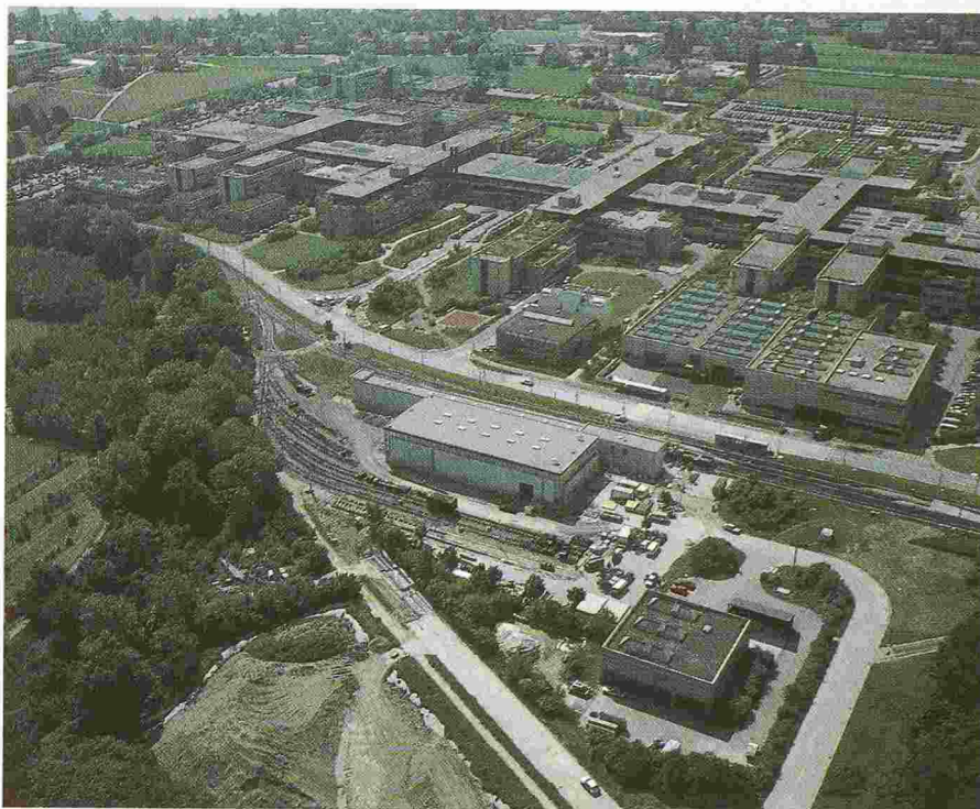
Fig. 6. – Dépôt-atelier: vue aérienne.
