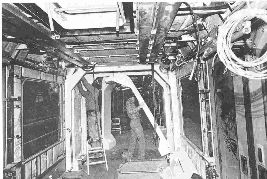
Fig. 4. – Travaux de montage à l'intérieur du caisson.
