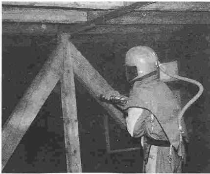
L'ancienne structure porteuse est sablée et reste apparente sous la nouvelle structure de toit à pans semi-ventilés.
