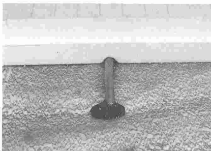
Selon la norme SIA 238, les conduites électriques et autres installations similaires seront posées côté interne de la feuille d'étanchéité à l'air. Ce tube électrique est posé au-dessus de pare-vapeur et de la feuille d'étanchéité, qu'il traverse. Le pare-vapeur doit être raccordé de manière étanche au tube électrique traversant.
