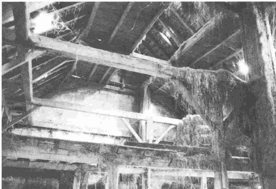
La grange du Spittelhof, à Zofingue, avant rénovation.
