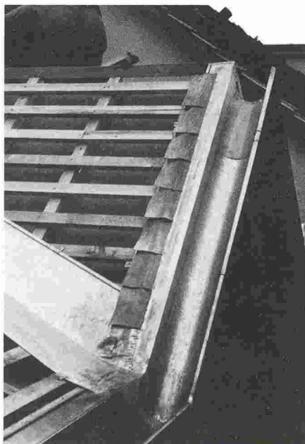
Quand on aménage des combles, il faut le plus souvent refaire aussi la ferblanterie.
