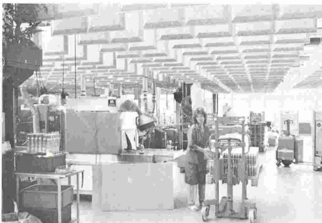
Fig. 10. - Élément absorbant Idikell B 208 suspendu dans une usine.
