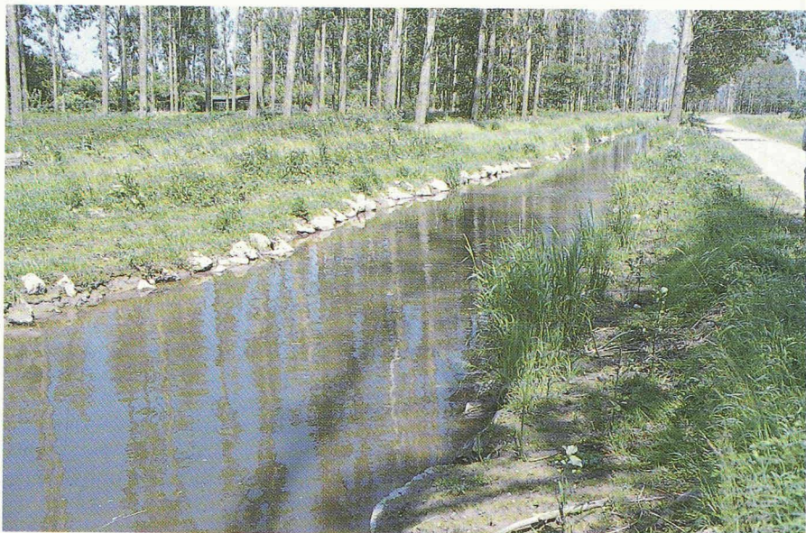
Wieseck. Le ruisseau de plaine régularisé et protégé par des empierrements dans la périphérie de Giessen.
