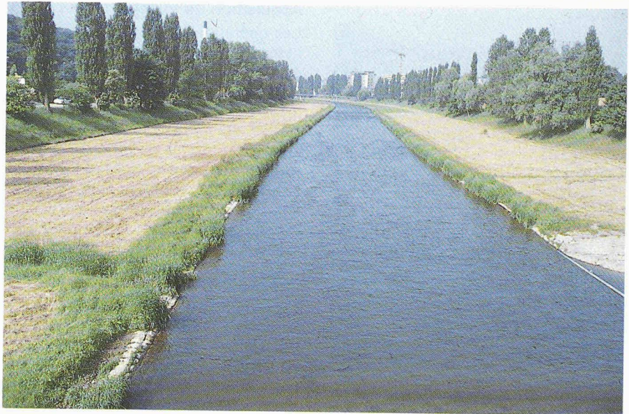
Enz. Dans la zone urbaine de Pforzheim, cette rivière, qui prend ses origines dans la Forêt-Noire, a été canalisée au début du siècle. Ses larges rives devaient être fauchées régulièrement. (Photo Becker.)
