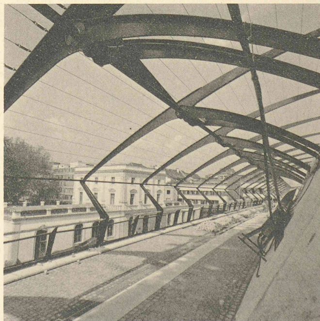
La gare de Zurich-Stadelhofen.
