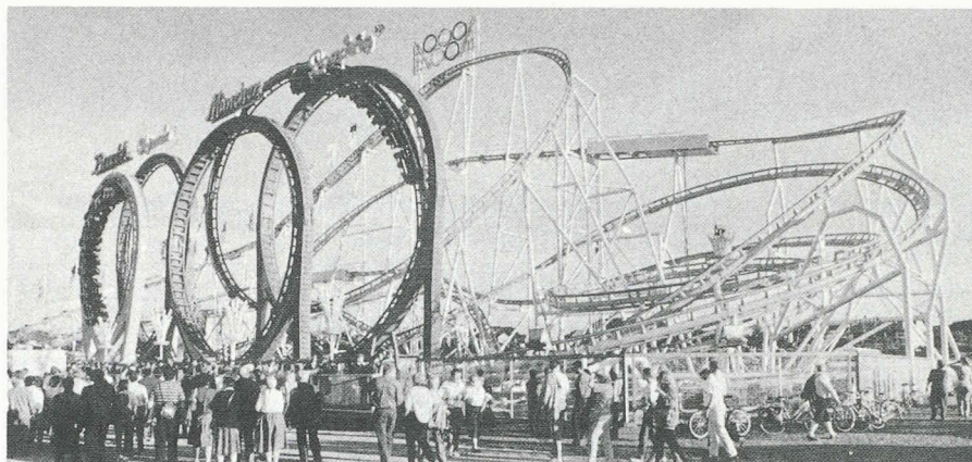
Fig. 8. – Structure de montagnes russes avec cinq loopings par W. Stengel, Munich. Une «sculpture technique» de 850 t d'acier démontable.
