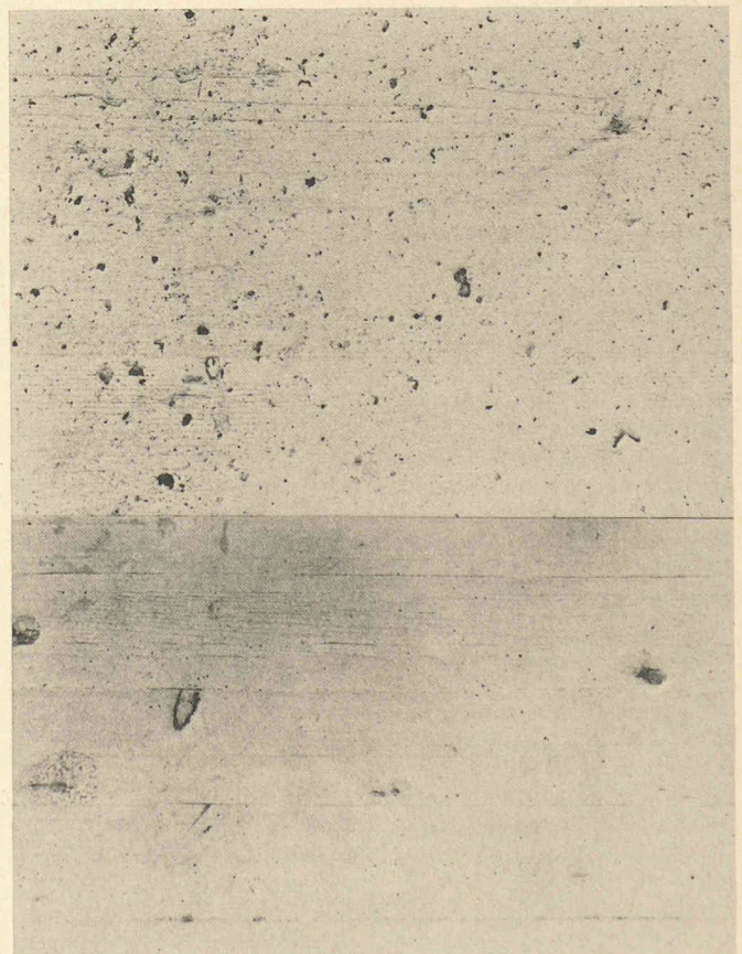
En haut: surface de béton dont le coffrage n'a pas été préparé. De grosses inclusions d'air sont visibles. En bas: coffrage traité avec Rheofinish; il en résulte une surface de béton sans pores.
