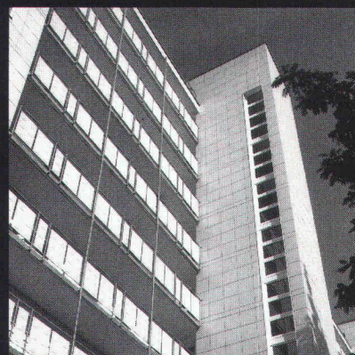
Logements Grosswiesenstrasse, Zurich (Caisse de Pension HG Commerciale, Zurich)
