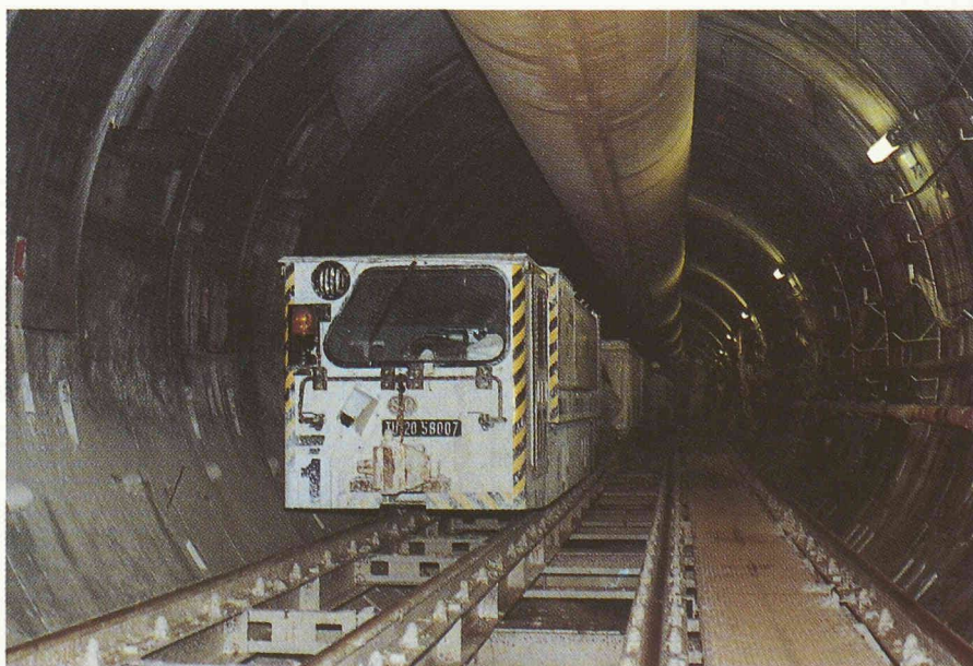
Fig. 10. - Locomotive V20, ici en tête d'un train d'évacuation des matériaux.
