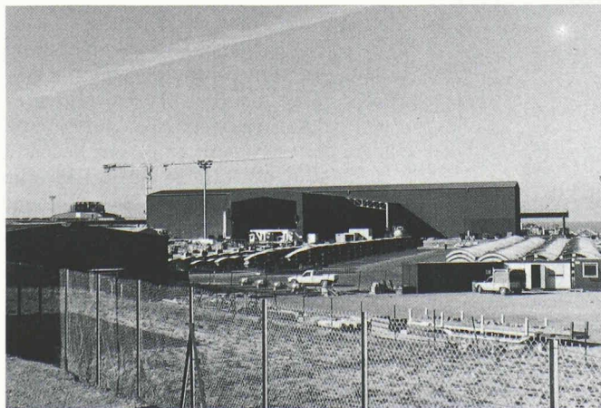
Fig. 2. - Abri en forme de hangar, situé au centre du chantier de Sangatte.
