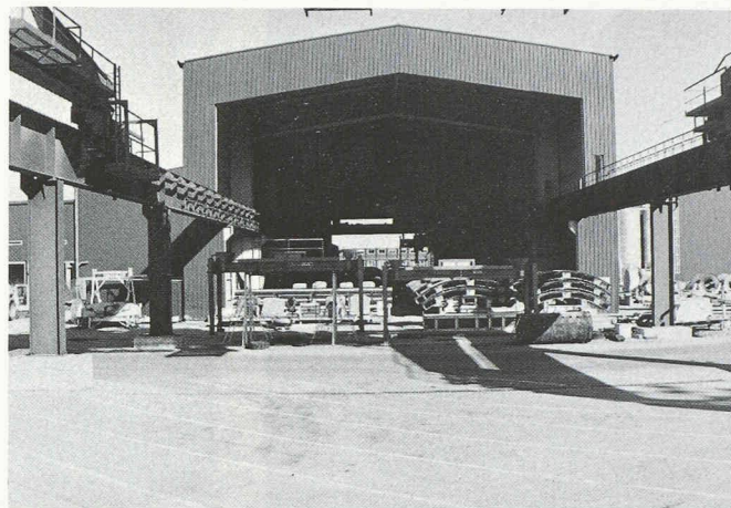
Fig. 8. - Sangatte. Le puits est desservi notamment par une grue portique d'une capacité de 430 t.
