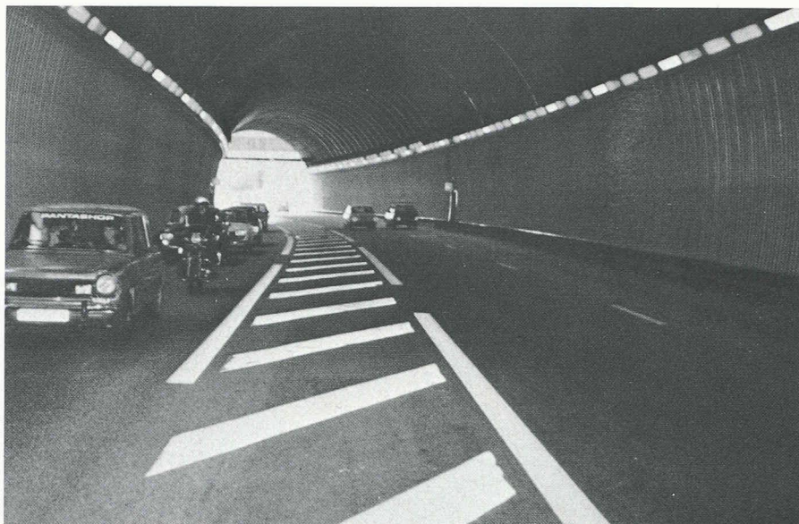
Fig. 9. - Séparation des voies dans un tunnel bidirectionnel.
