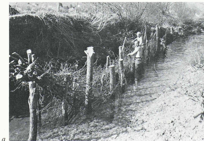
Fig. 8. – Protection par fascines. (a) La réalisation des constructions végétales nécessite des personnes compétentes comme dans toute construction (30.3.1989). (b) La grande niche d'érosion a été activement protégée par un mur de fascines complété par des sacs de géotextiles (8.4.1989). (c) Les végétaux offrent un «mur» inattaquable et une diversité biologique remarquable. Le cours d'eau ressemble à une rivière naturelle (7.9.1990).
