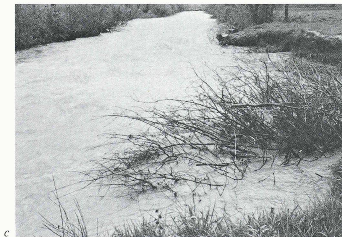
Fig. 7. – Technique du peigne. (a) Des arbres et buissons branchus sont placés dans la niche d'érosion (1984). (b) Les éléments en suspension dans l'eau sont retenus par effet de filtre dans les branches lors de la crue (1985). (c) La berge se reconstitue par accumulation des sédiments et la végétation du «peigne» se développe en contribuant à la fixation de la berge (1991).
