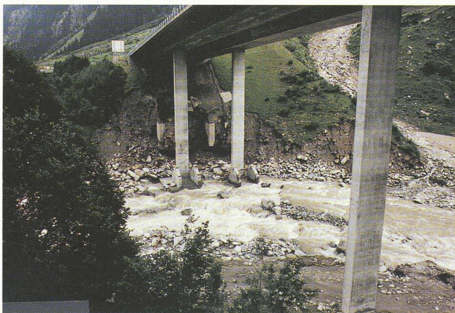
Fig. 13. – La rive droite près de la culée nord, et les piles B/G. (Photo: T. R. Schneider, 1878/25.)
