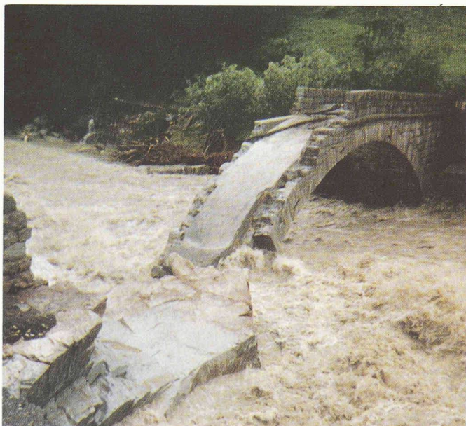
Fig. 3. - Le Schluchenbrüggli en amont du pont sur la Reuss à Wassen. (Photo: R. Kalbermatten.)
