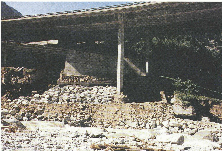
Fig. 12. – 15 000 m 3 de pierres et de matériaux de carrière, réussite du soutien de la culée et du mur de soutènement le 29 août 1987 à minuit. (Photo: T. R. Schneider, 1879/8.)
