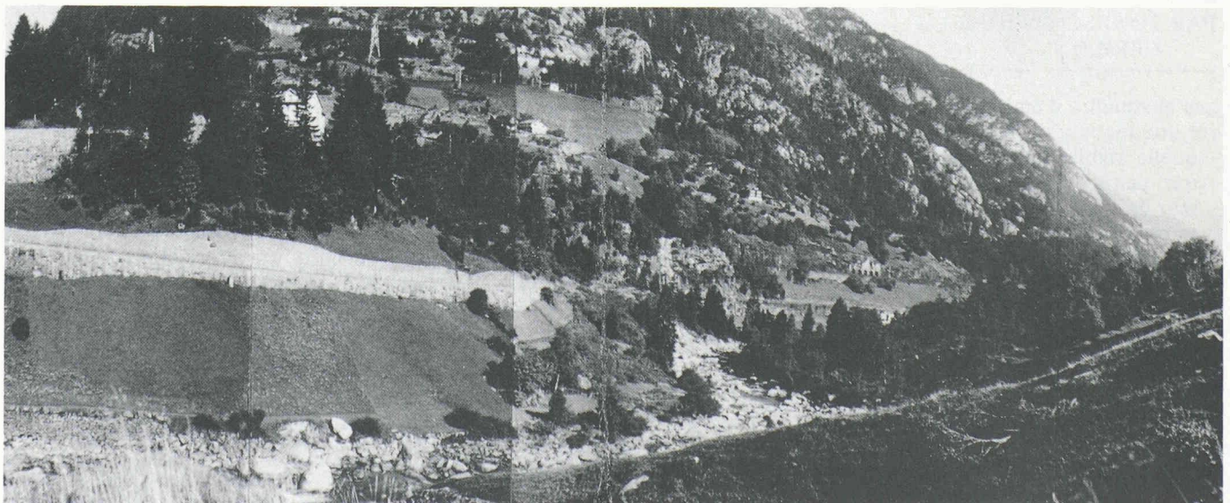
Fig. 9. - Le lit de la Reuss avant la construction du pont; vue vers l'aval.
