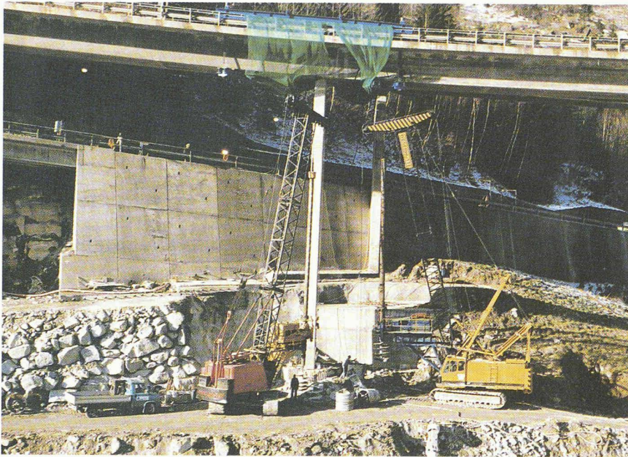
Fig. 5. – Deux engins en train de forer les pieux.
