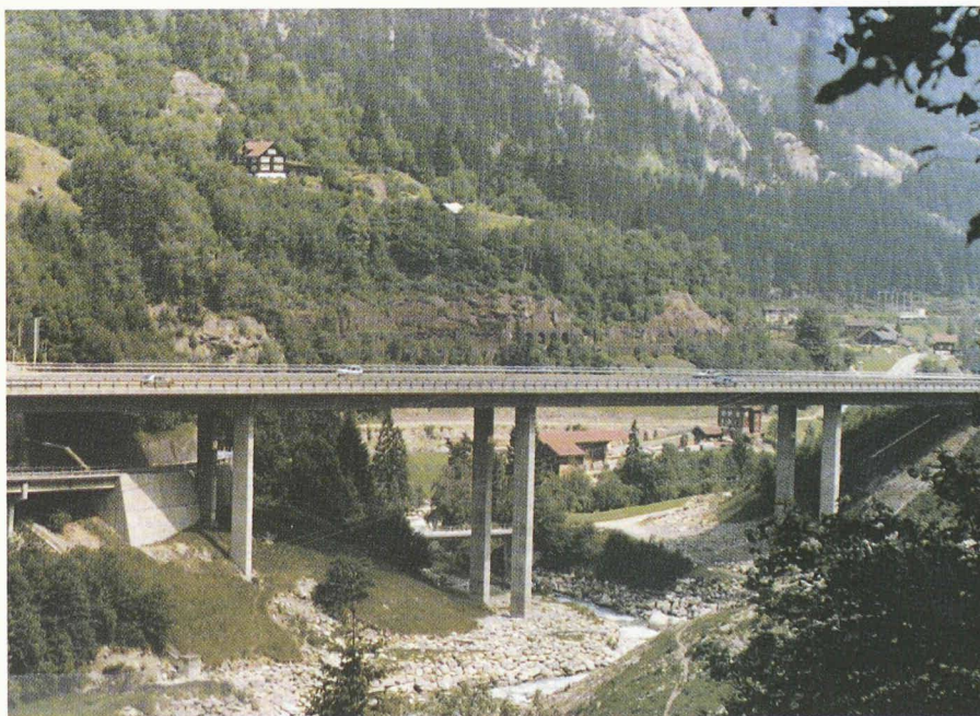
Fig. 1. – La Reuss et le pont de Wassen avant les intempéries de 1987.
